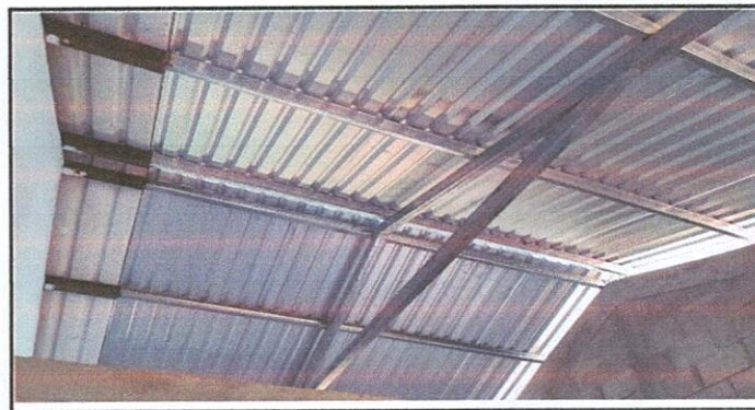
Foto 6: Mejoramiento estructura de metal con techo
