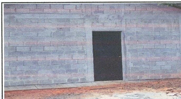
Foto 3: Mejoramiento de puertas
