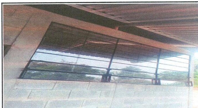
Foto 4: Mejoramiento de ventanas
